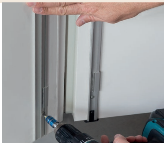
* 1. fáze montáže - montovány jen upevňovací lišty
